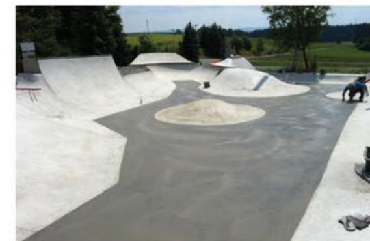
Die Ortbeton-Bauweise ermöglicht optimale Anpassung an die Gegebenheiten vor Ort, das verfügbare Budget und besondere Nutzerwünsche. Alle Anlagen werden selbstverständlich nach Anforderungen der DIN EN 14974 erstellt und auf Wunsch durch eine Sicherheitsprüfung abgenommen.
